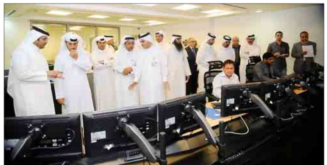
غرفة التحكم (تصوير سيد عمر)
